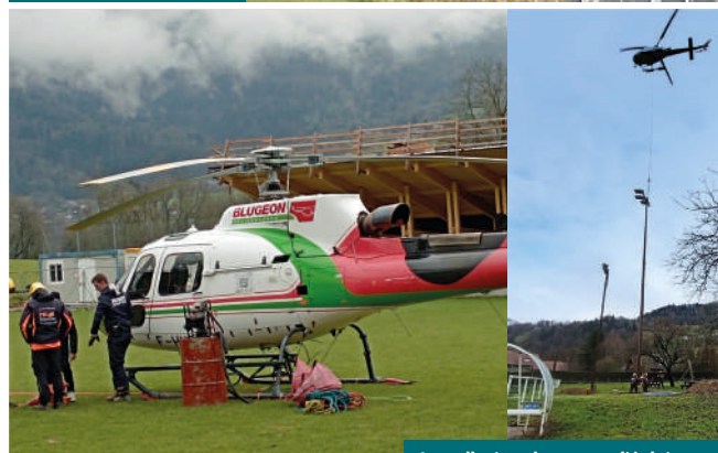
Installation des mats d'éclairage
